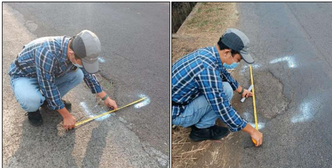
Gambar 10. Pengukuran dimensi kerusakan jalan dilapangan.
