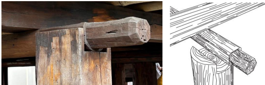
Gambar 4. SAMBUNGAN STRUKTUR TANGGAM PURUS LAMBAN PESAGI
