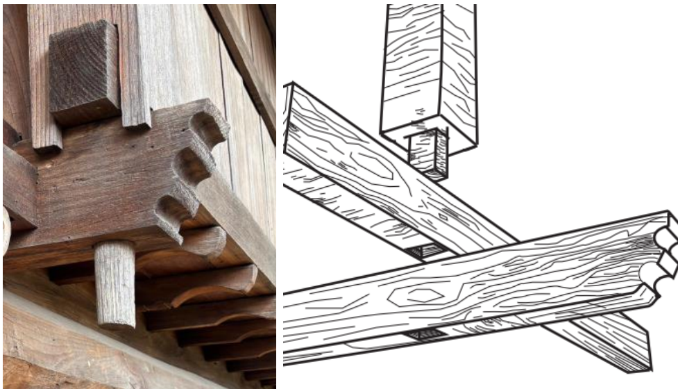
Gambar 5. SAMBUNGAN STRUKTUR PURUS TEGAK DAN JEPITAN ORNAMENTAL LAMBAN PESAGI
