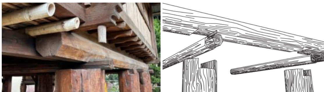
Gambar 3. SAMBUNGAN STRUKTUR ATUNG KALABAI LAMBAN PESAGI
