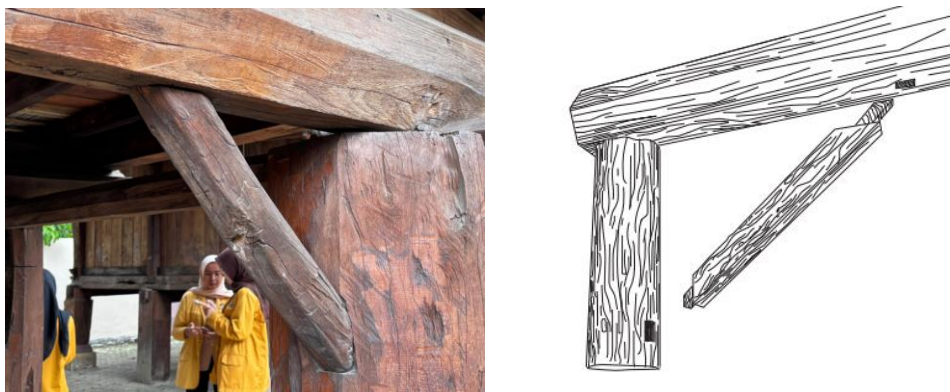
Gambar 2. SAMBUNGAN STRUKTUR PASAK KAYU LAMBAN PESAGI
