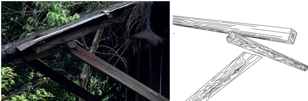
Gambar 6. SAMBUNGAN TANGGAM MIRING LAMBAN PESAGI
