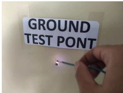
Gambar 10. Pengujian arus bocor
