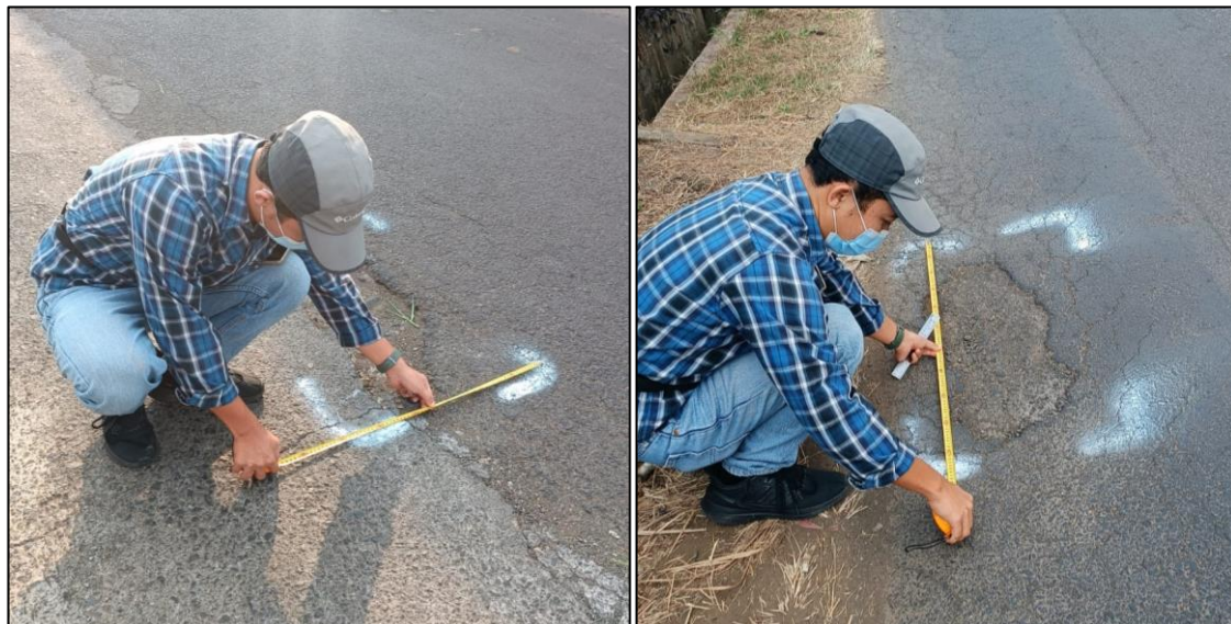
Gambar 10. Pengukuran dimensi kerusakan jalan dilapangan.
